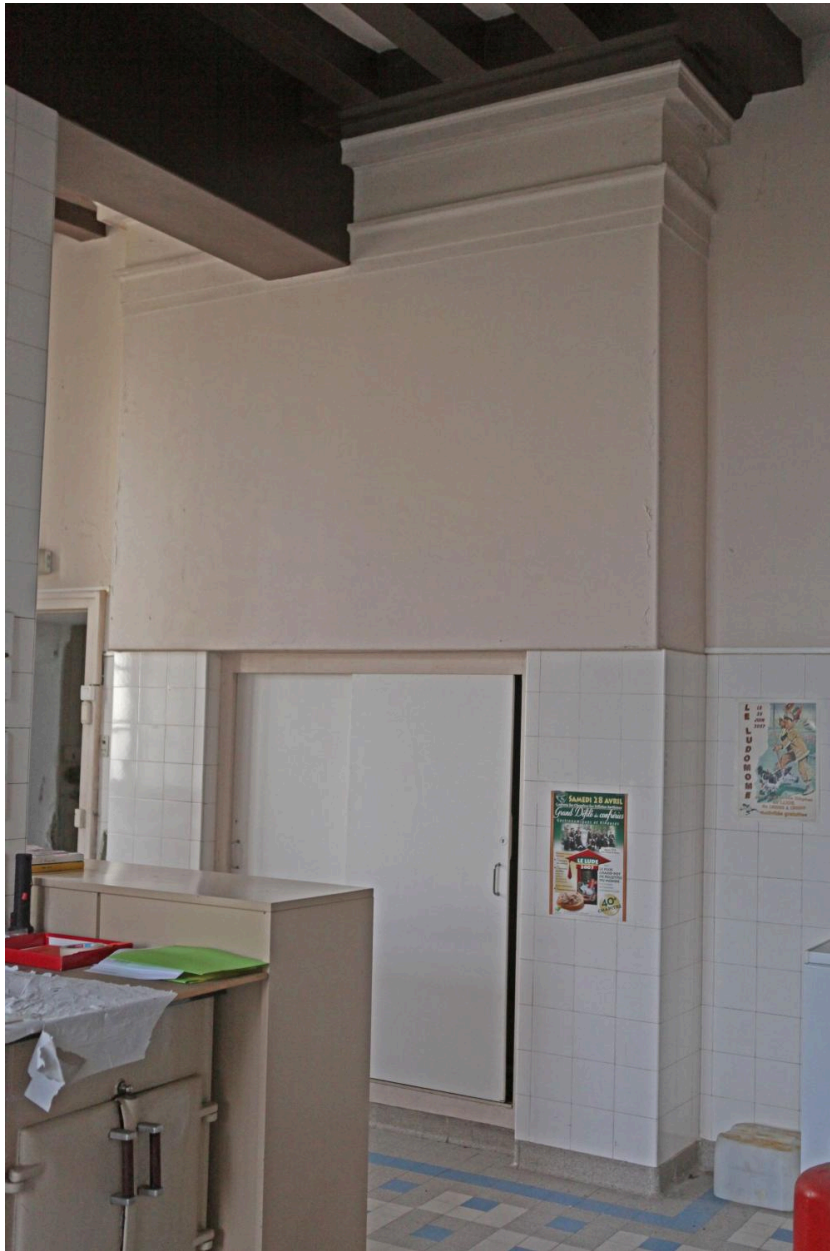
Rez-de-chaussée, 2e salle à droite : vestige d'une cheminée à hotte droite.
