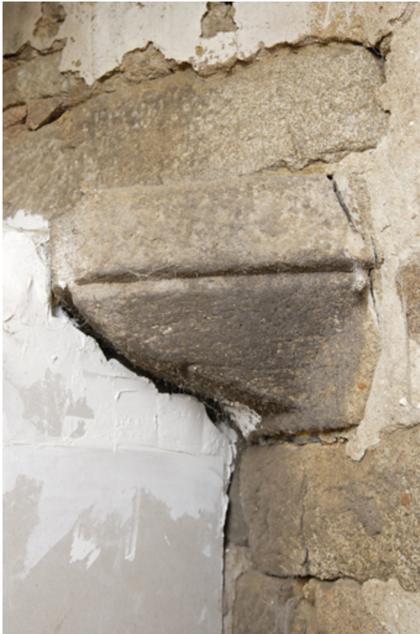
Logis. Tour d'escalier. 1er niveau. Détail du coussinet portant le linteau de la porte d'accès à la salle est.
