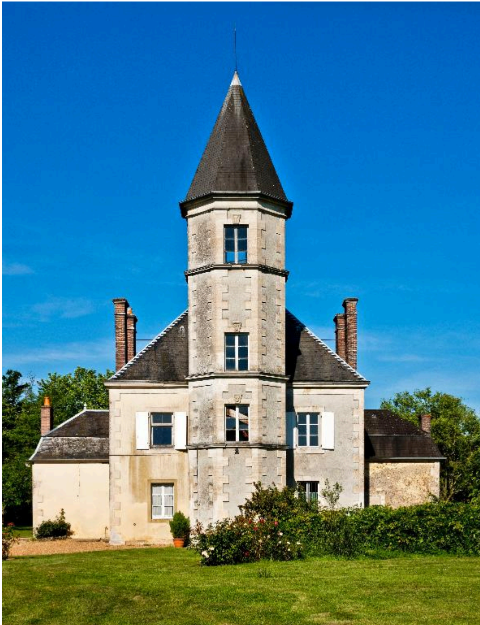
Elévation postérieure du logis.
