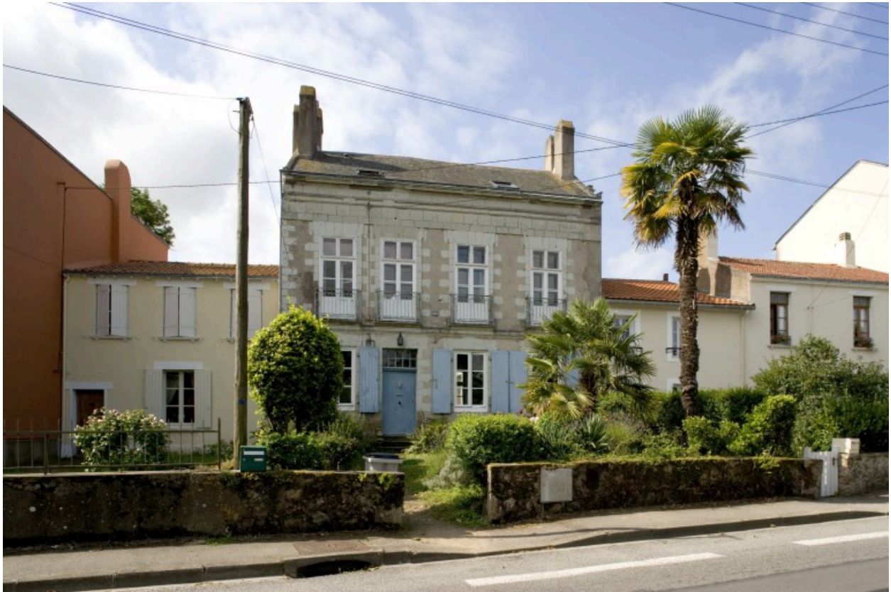
Maison, 20 quai Eole.
