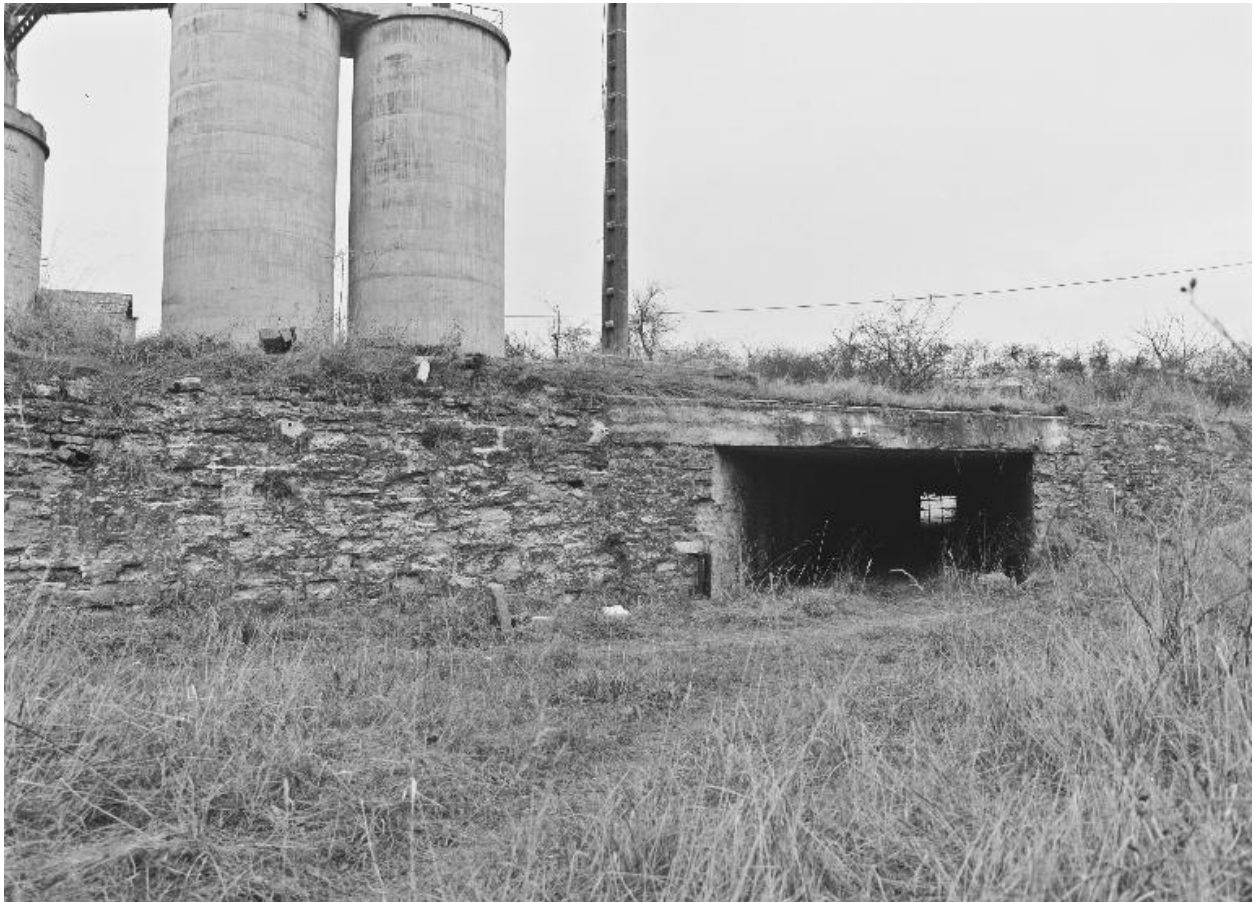
Usine de chaux : tunnel de circulation de la carrière à la base des fours
