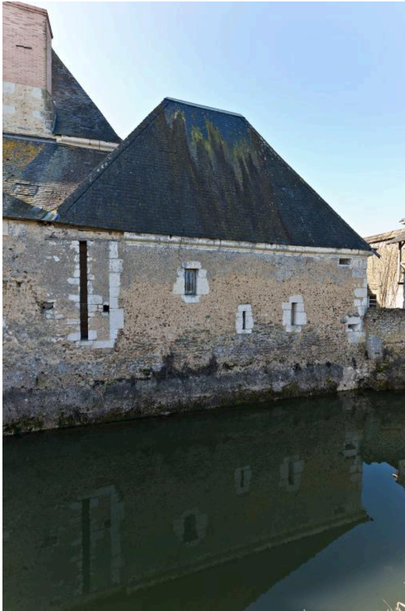
Aile nord-ouest, prise au-delà de la douve.
