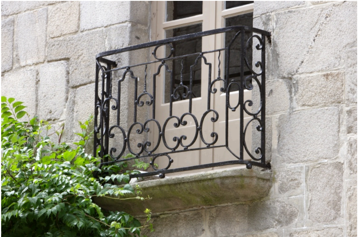
Façade sur rue, détail d'un balconnet.
