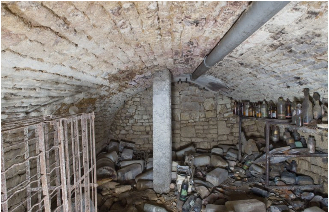
Sous-sol de la maison 16, place des Acacias.
