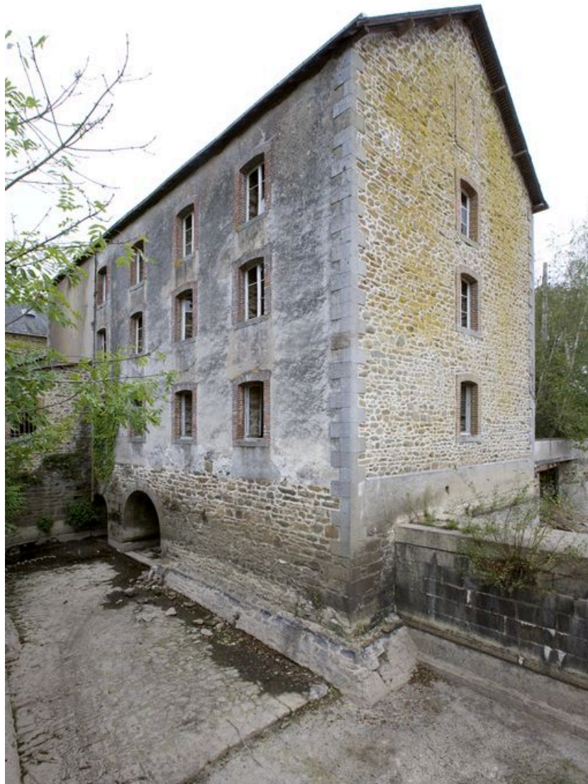
Le moulin vu depuis la plateforme d'aval du barrage, pendant les écourues de 2009.
