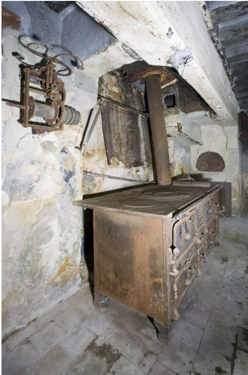
Cuisine de l'aile ouest : détail de la cheminée.
