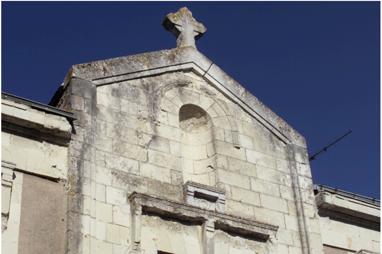
La façade postérieure, détail de la partie supérieure de l'avant-corps central.
