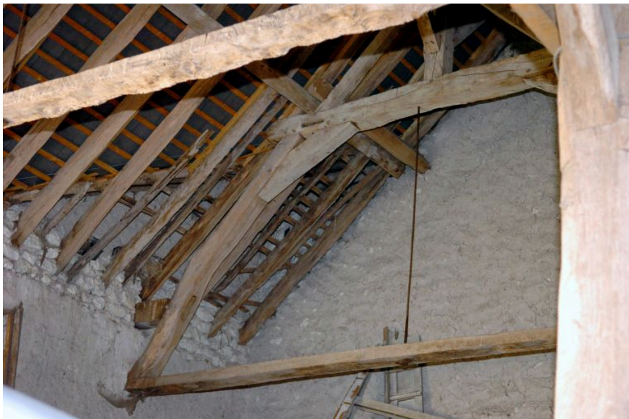
Charpente de la maison.
