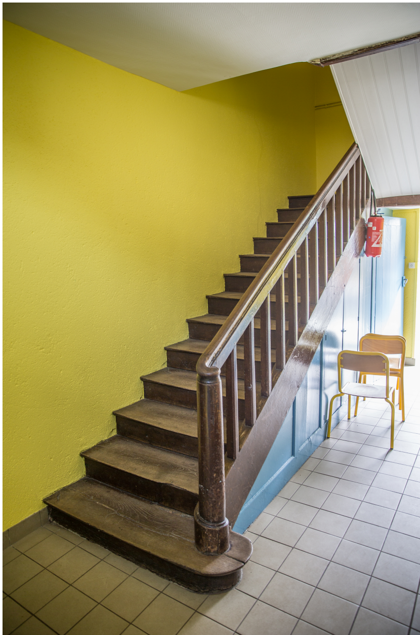
L'escalier du bâtiment principal.
