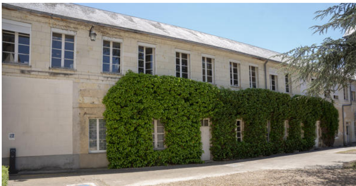
Atelier de fabrication A2 de l'usine de papeterie.
