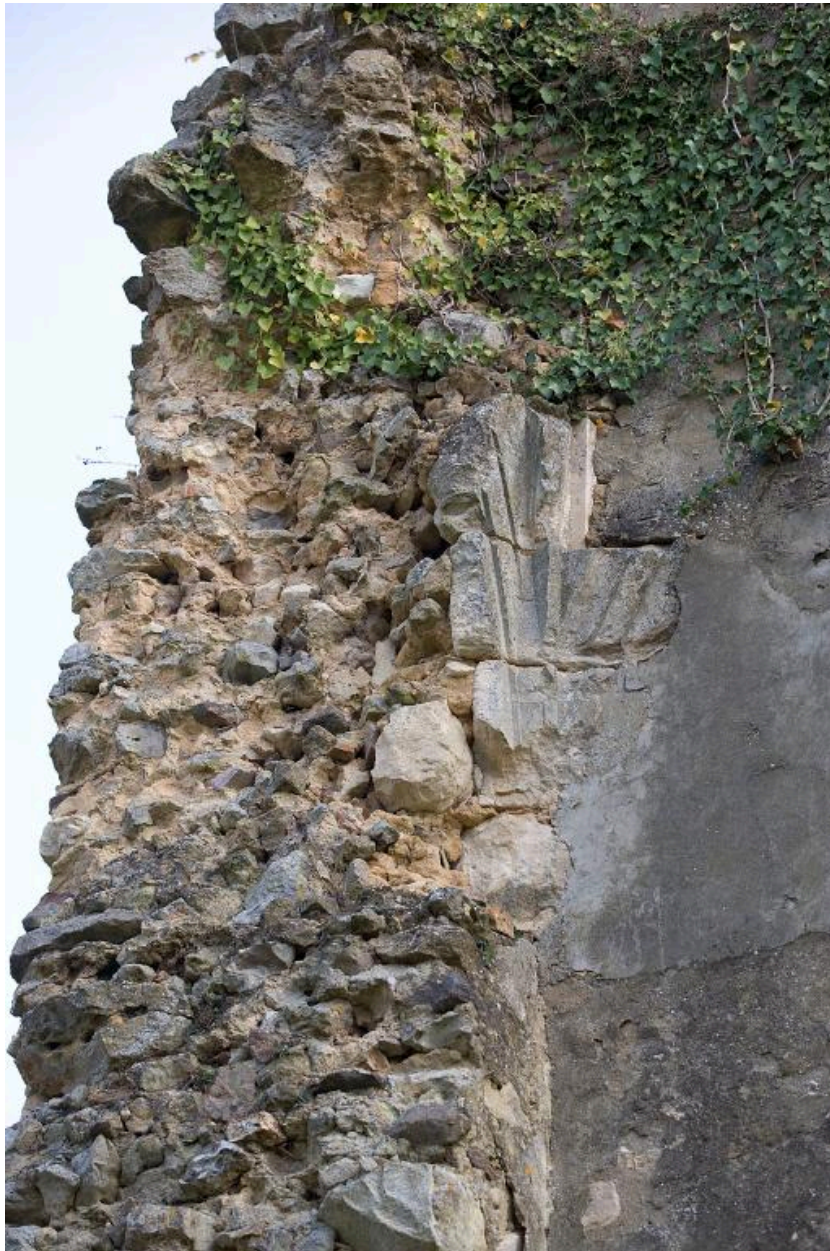
Le pavillon, façade ouest, détail de l'arrachement de l'aile sud et des voûtes, 2007.
