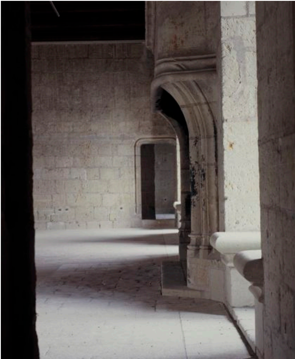
1er étage-carré : appartements du seigneur de Montsoreau, grande salle, vue depuis l'entrée de la chambre de parement.
