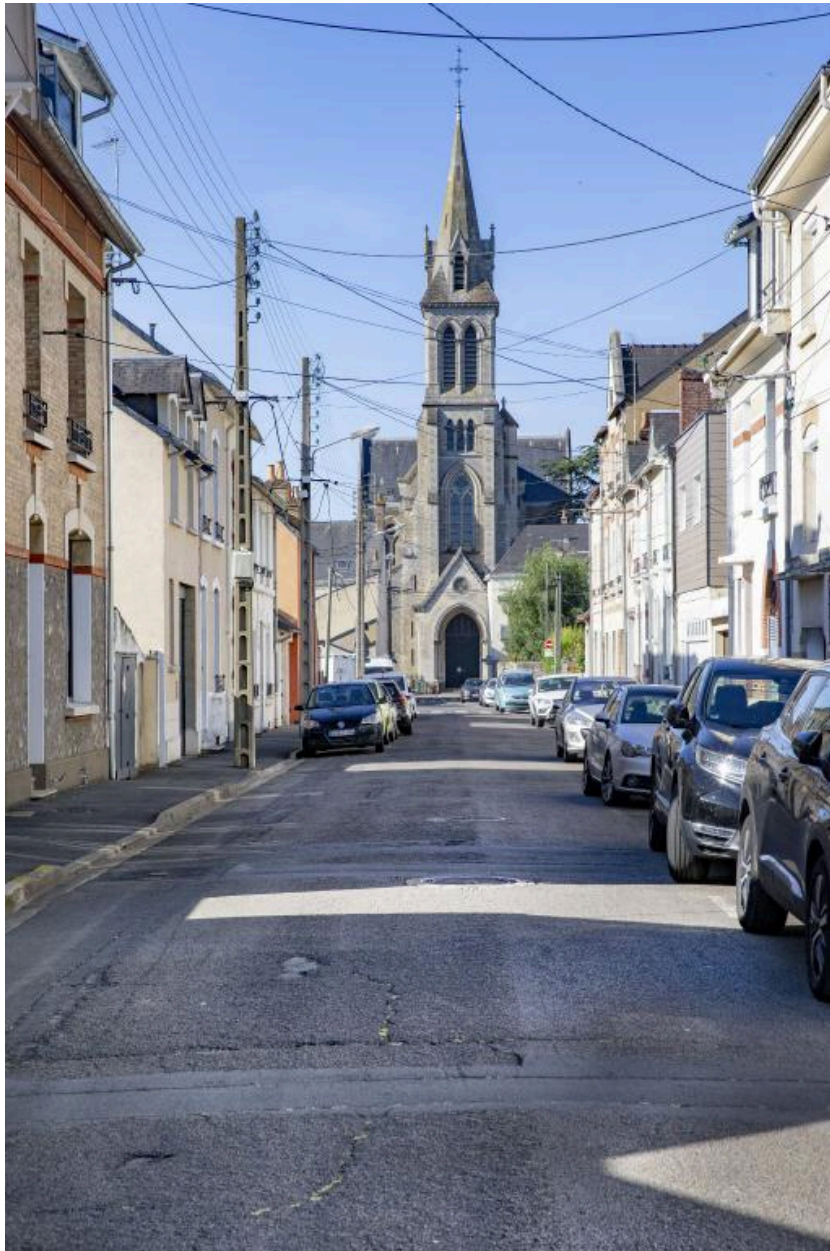
Vue de l'église Saint-Pavin, rue Gallieni.
