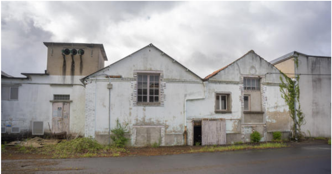
Vue des ateliers A depuis le nord.
