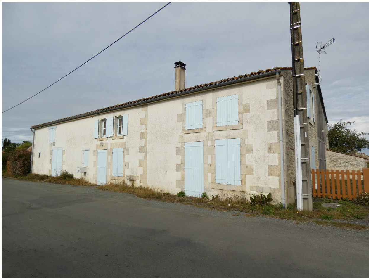
Le logis vu depuis le sud-est.
