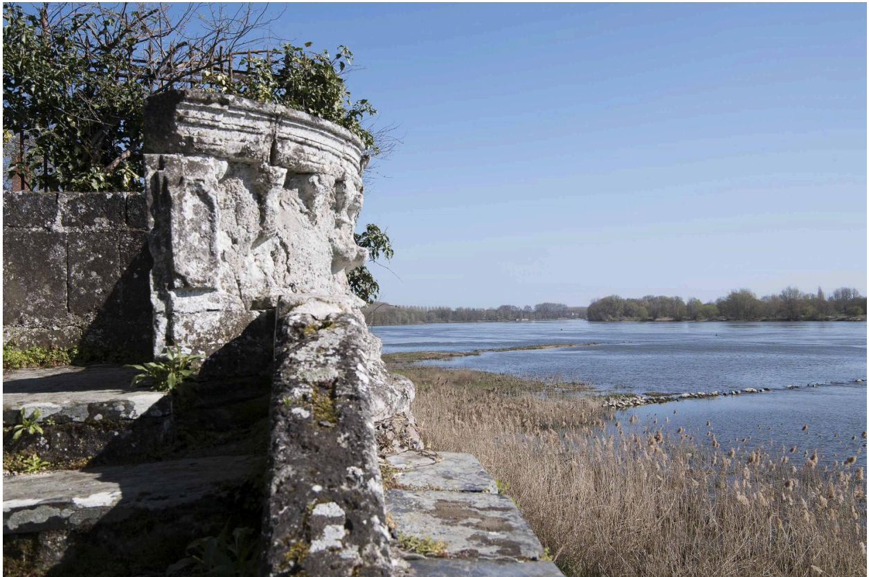
Vue de la Loire depuis la tourelle nord.
