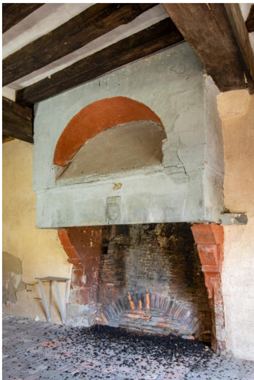
La cheminée de la salle du rez-de-chaussée.
