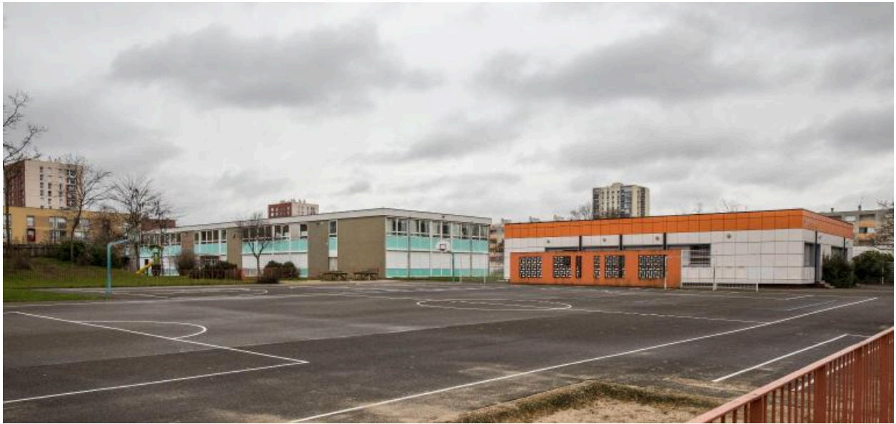
Vue de l'école Gérard-Philippe et du restaurant scolaire depuis le sud.
