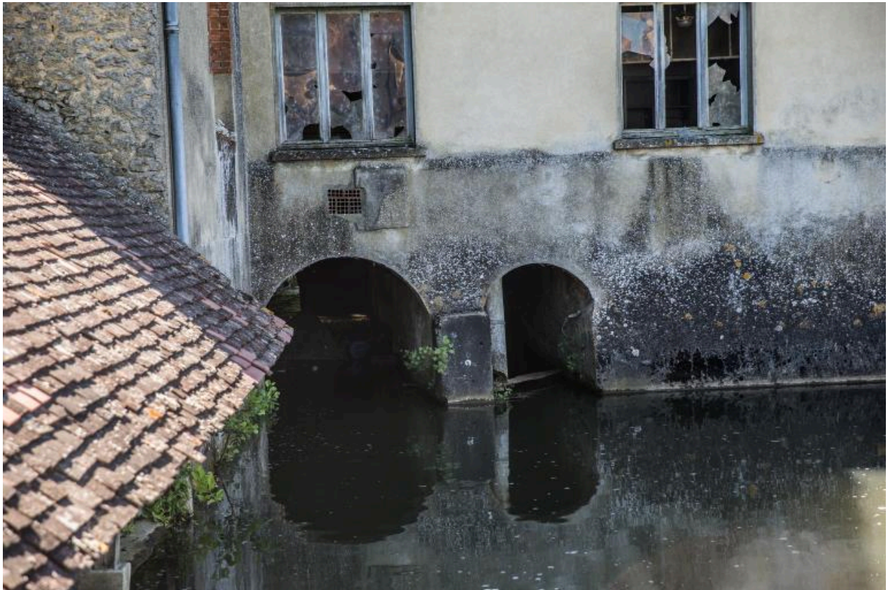
La façade sur le Dué, détail du passage d'eau.
