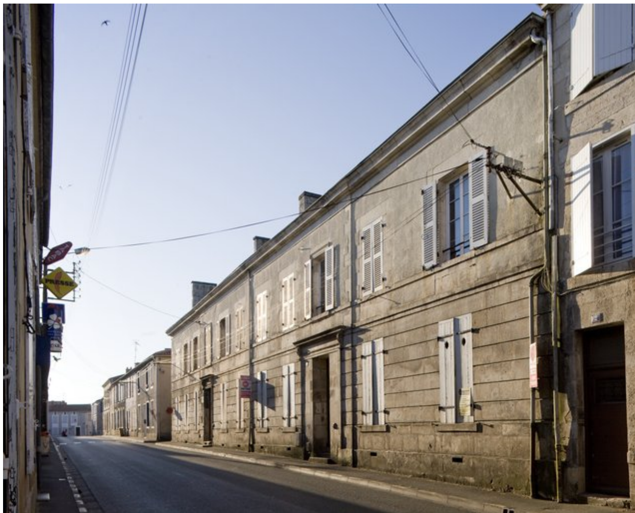
Vue d'ensemble de la façade sur rue, prise de l'ouest.
