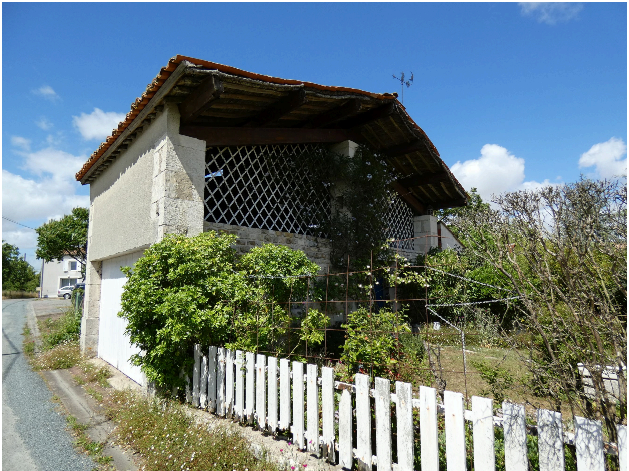
La dépendance, avec fenil, au nord de la cour, vue depuis le sud.
