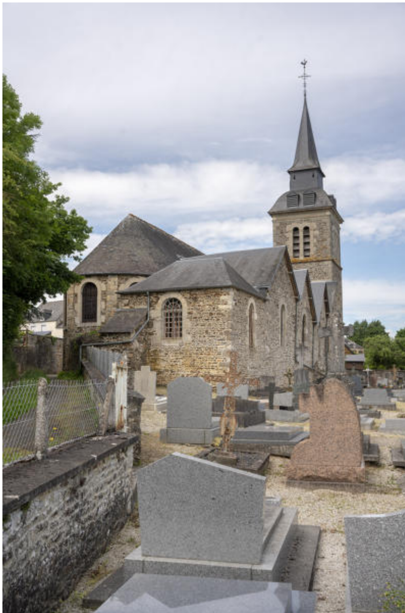
L'église depuis le nord-est, côté cimetière.
