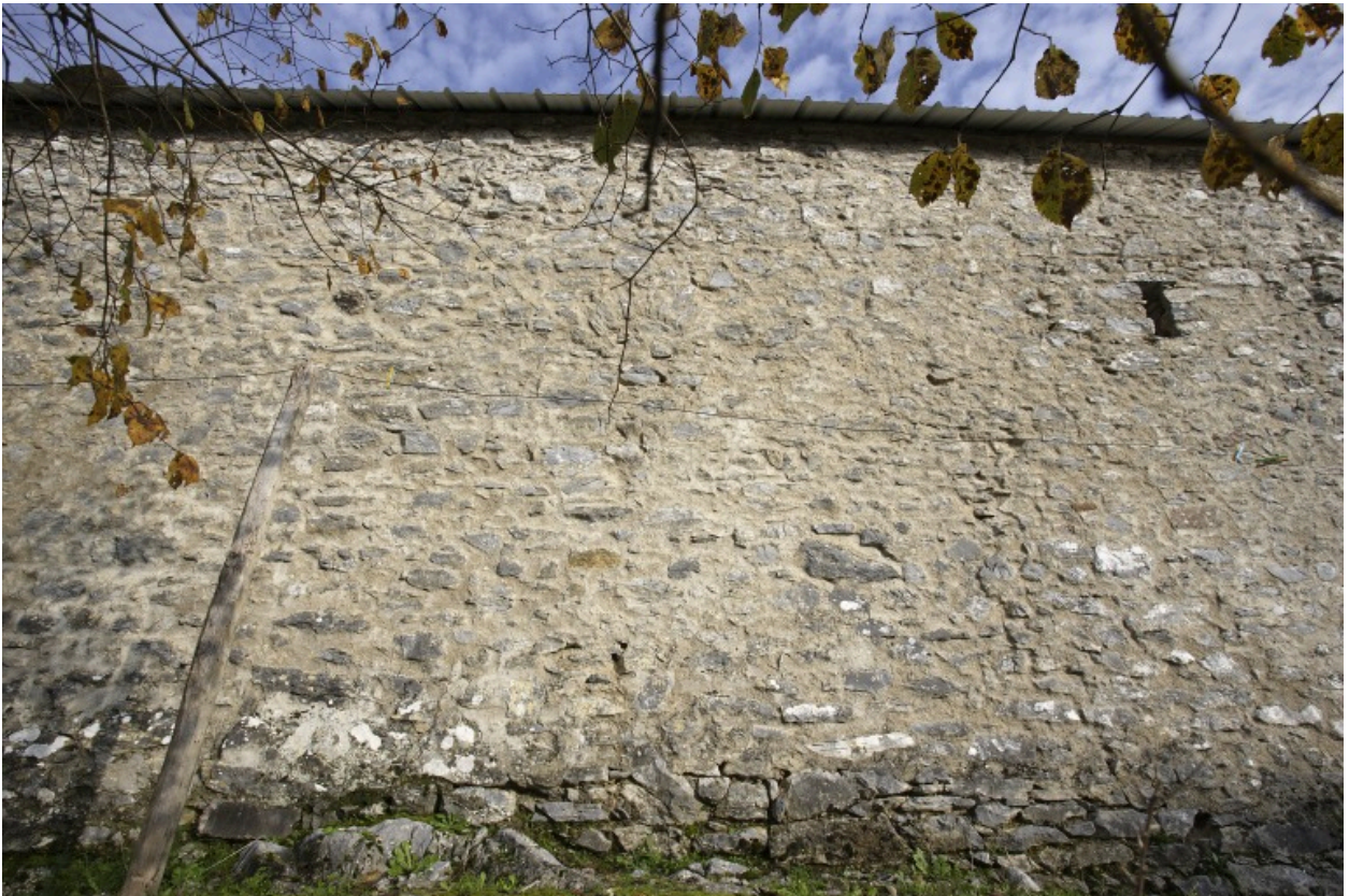
Bâtiment sud : partie centrale de la façade sud
