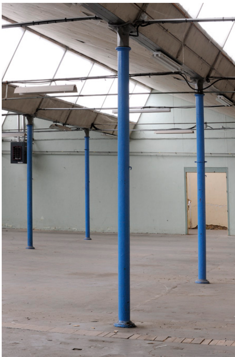
Détail des piliers en fonte.
