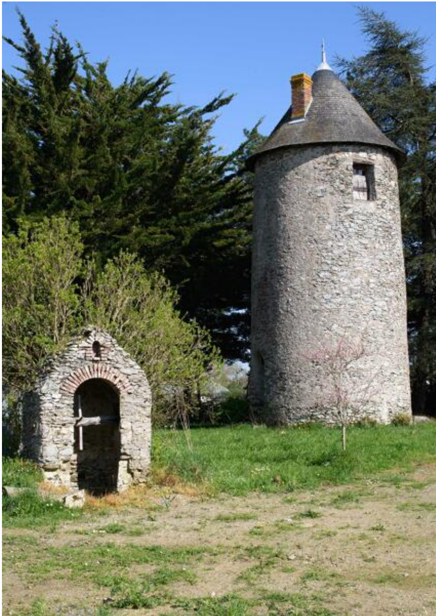
Moulin à farine dit moulin des Buttes (n° 1) ou moulin de l'Ouche-Neuve. Vue d'ensemble depuis l'ouest.
