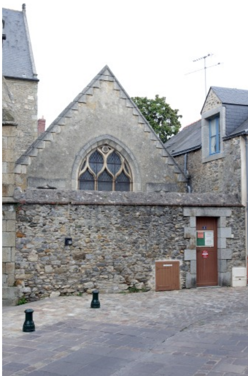
Chapelle de semaine, élévation sud : vue d'ensemble.
