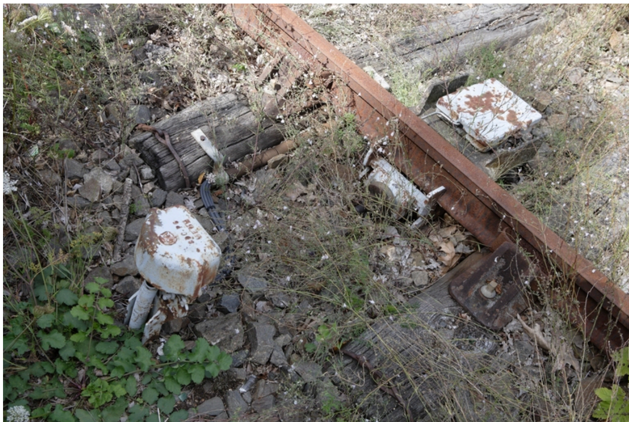
Pédales de réarmement et boîtier de jonction, PN 312, côté Châteaubriant.
