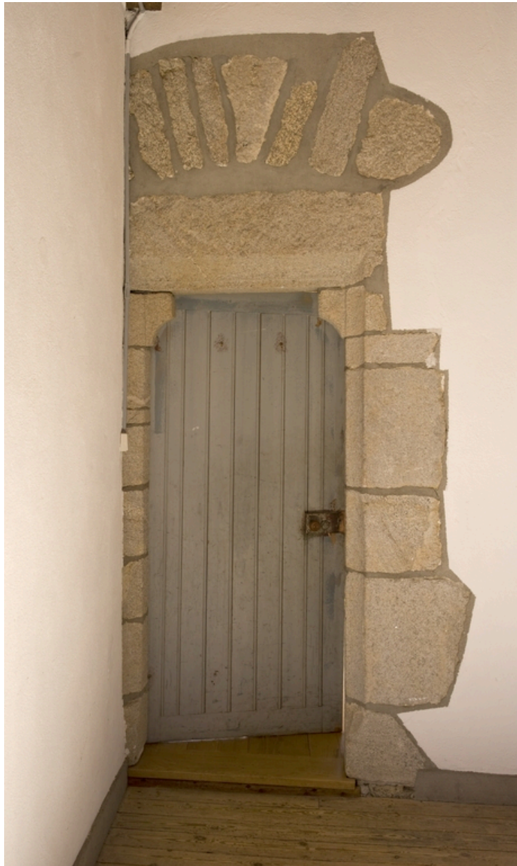
Pavillon. 1er étage. Salle sud. Porte d'accès à la salle nord.
