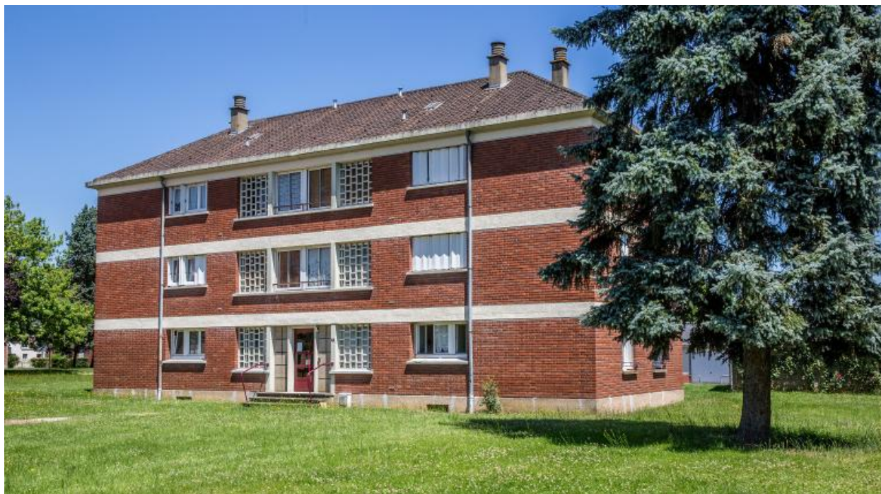
Vue d'un plot au centre de l'îlot.
