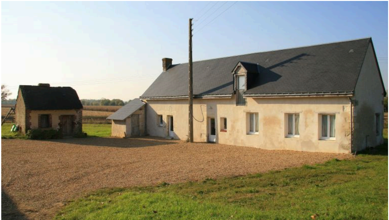
Vue d'ensemble de la maison d'habitation et de la buanderie.
