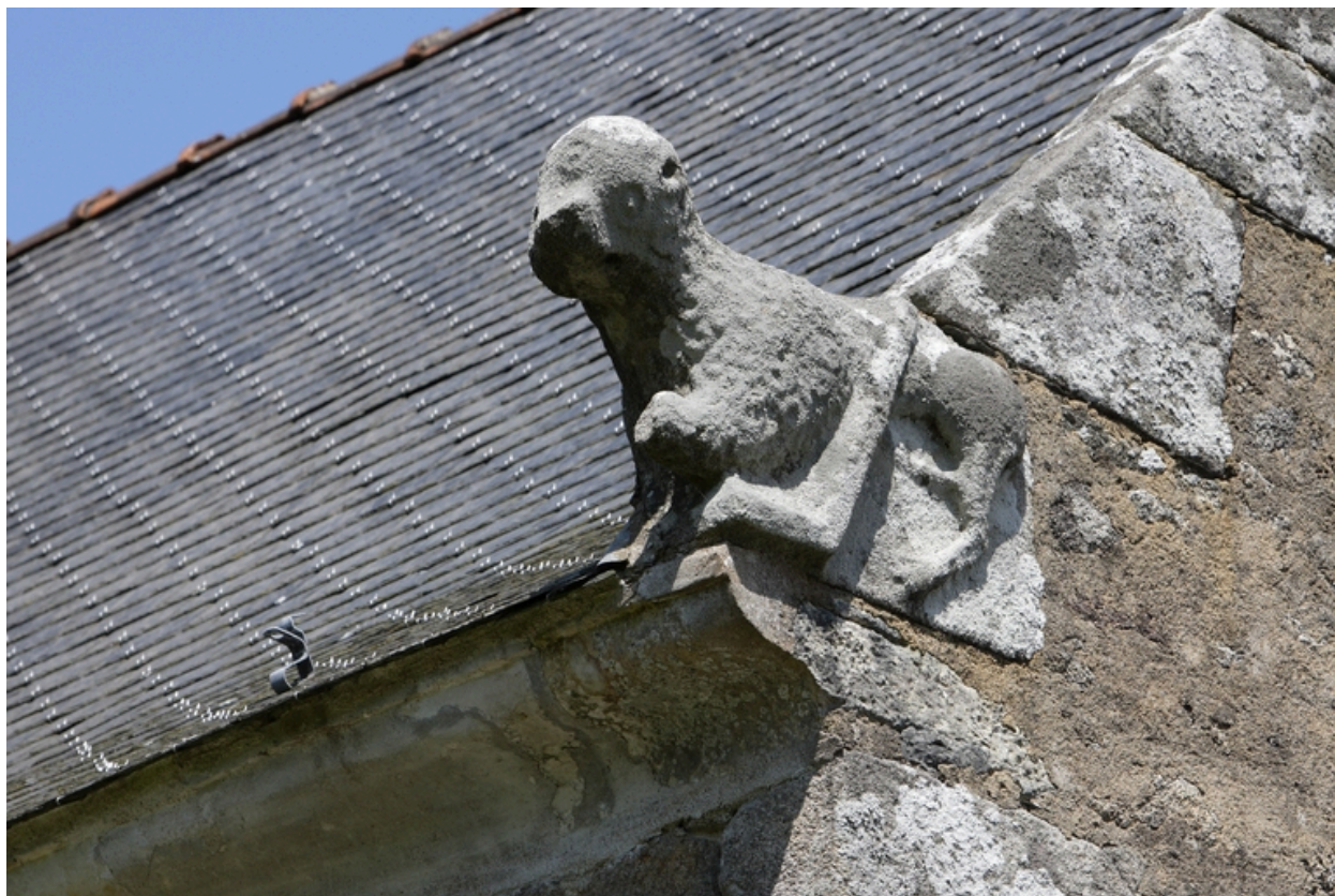
Façade ouest. Détail de l'acrotère dans l'angle nord-est.
