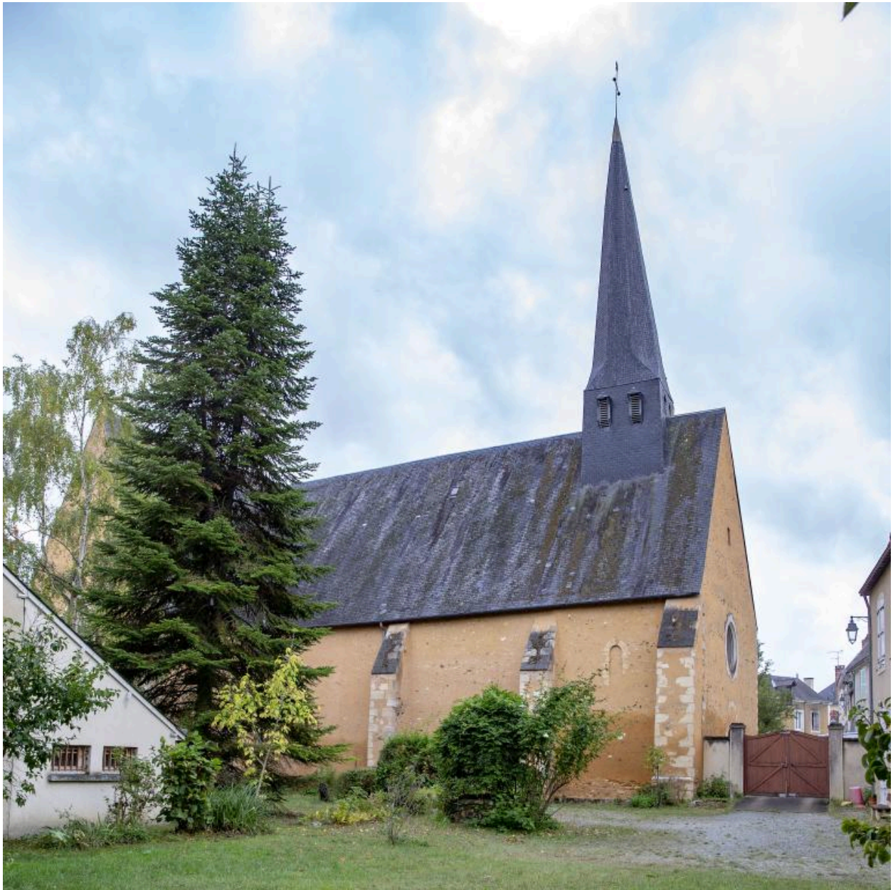
La nef, la flèche et le pignon nord depuis le jardin du presbytère.
