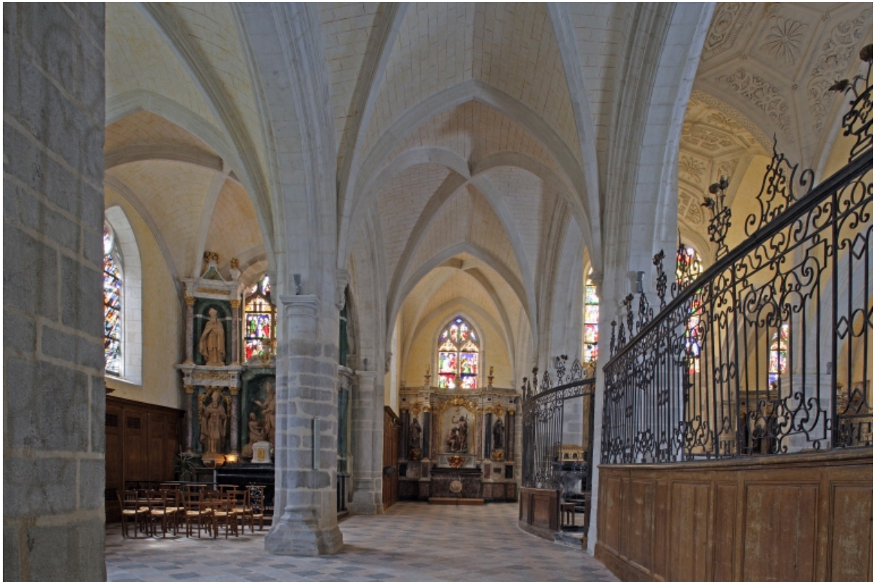
Choeur, collatéraux gauche après restauration : vue d'ensemble depuis le bras gauche du transept.
