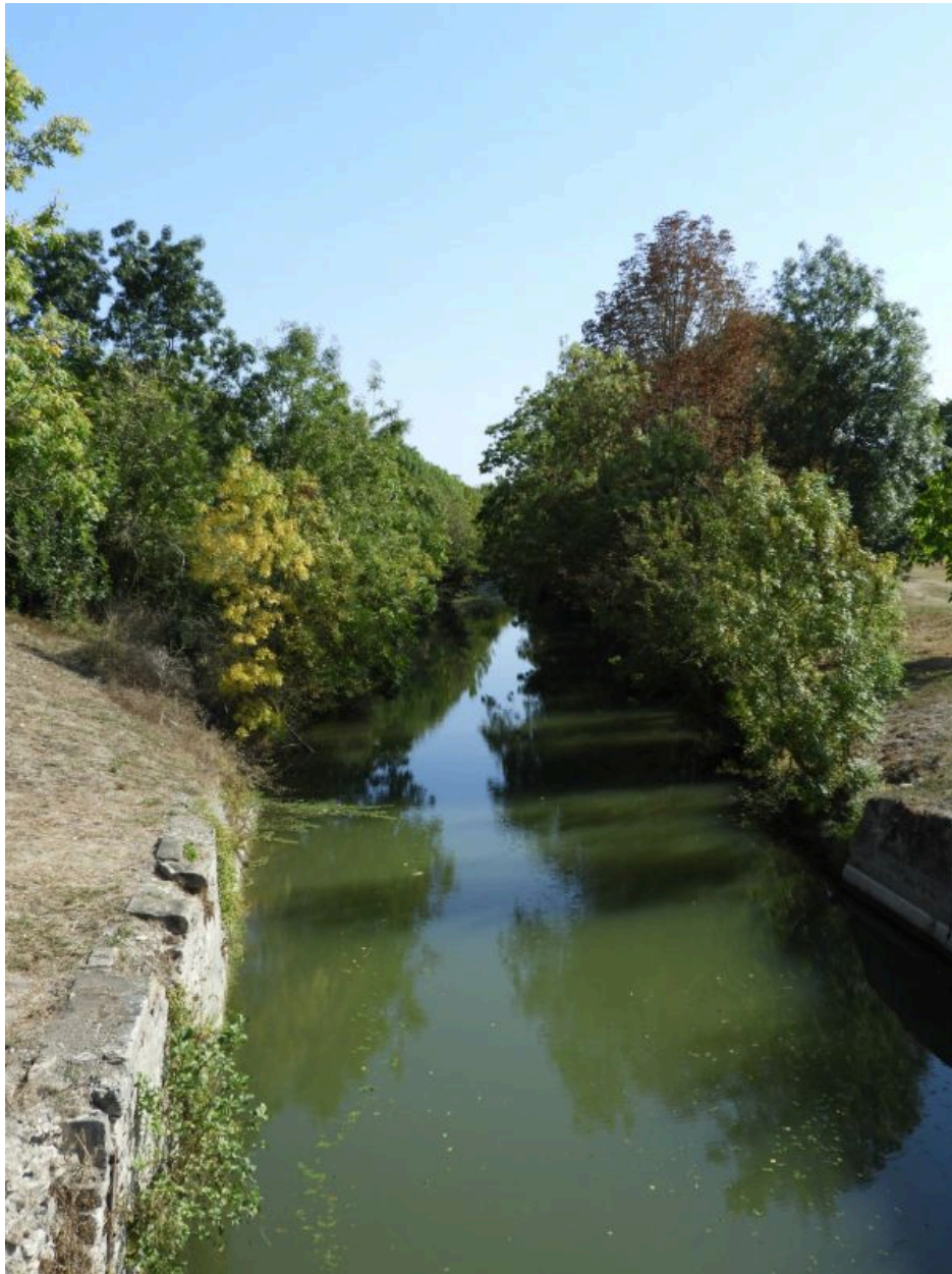
Le canal de Vix en amont de l'aqueduc vu depuis celui-ci, en direction de l'est.
