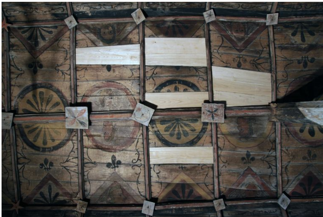
Nef, voûte lambrissée, côté sud, deuxième travée : registre de façade après les travaux effectués en 2010.
