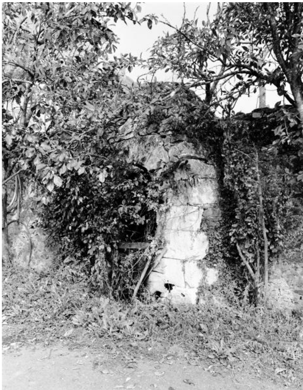
Vue d'ensemble du puits.
