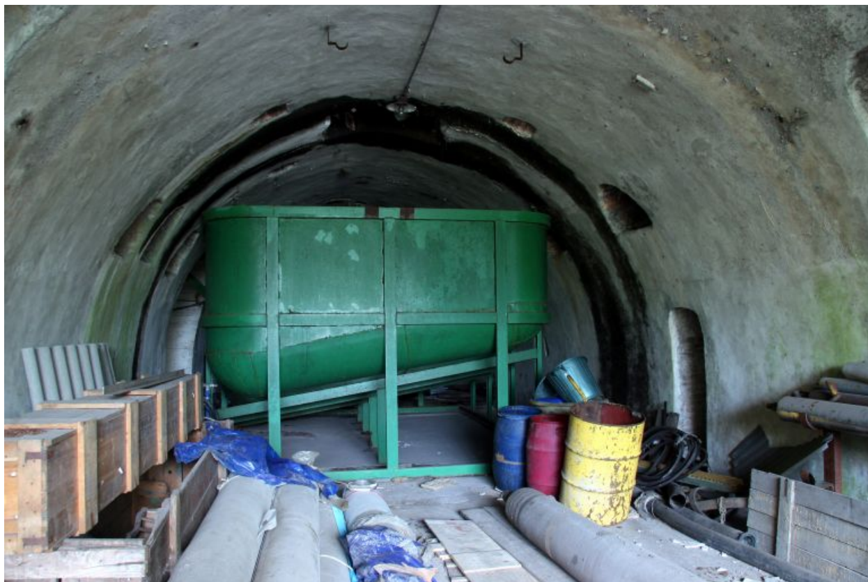
Rez-de-chaussée, vaisseau voûté transversal avec un cuvier de stockage de la pâte.
