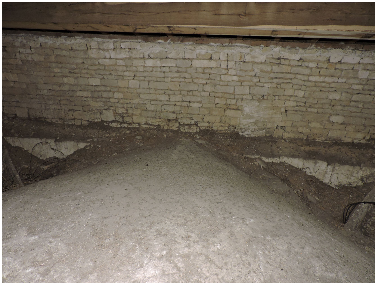
La voûte de la première travée du chœur, côté sud.
