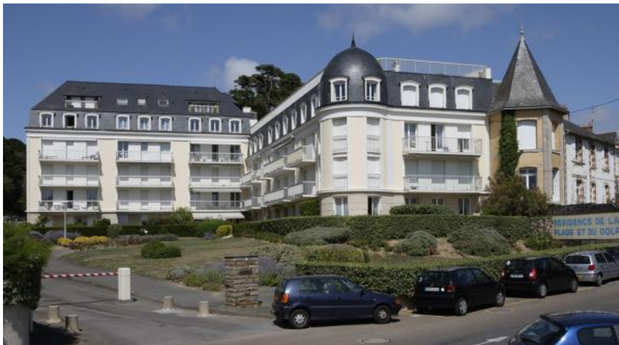
Vue d'ensemble, côté sud, état actuel de l'hôtel de voyageurs dit de la Plage.
