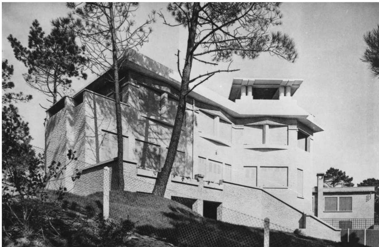
Façade sud de la villa Anto puis La Corvette vue du sud-ouest.
