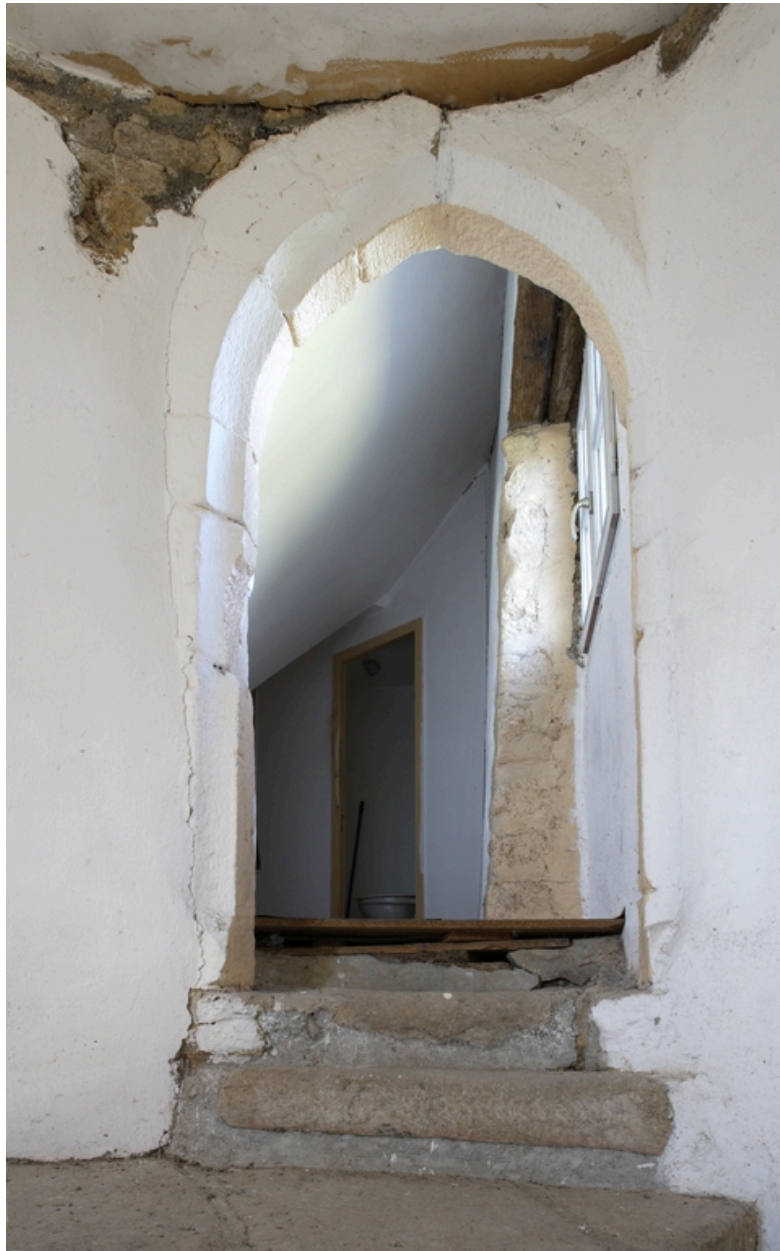
Aile ouest. Étage de comble. Détail de la porte d'accès aux combles.
