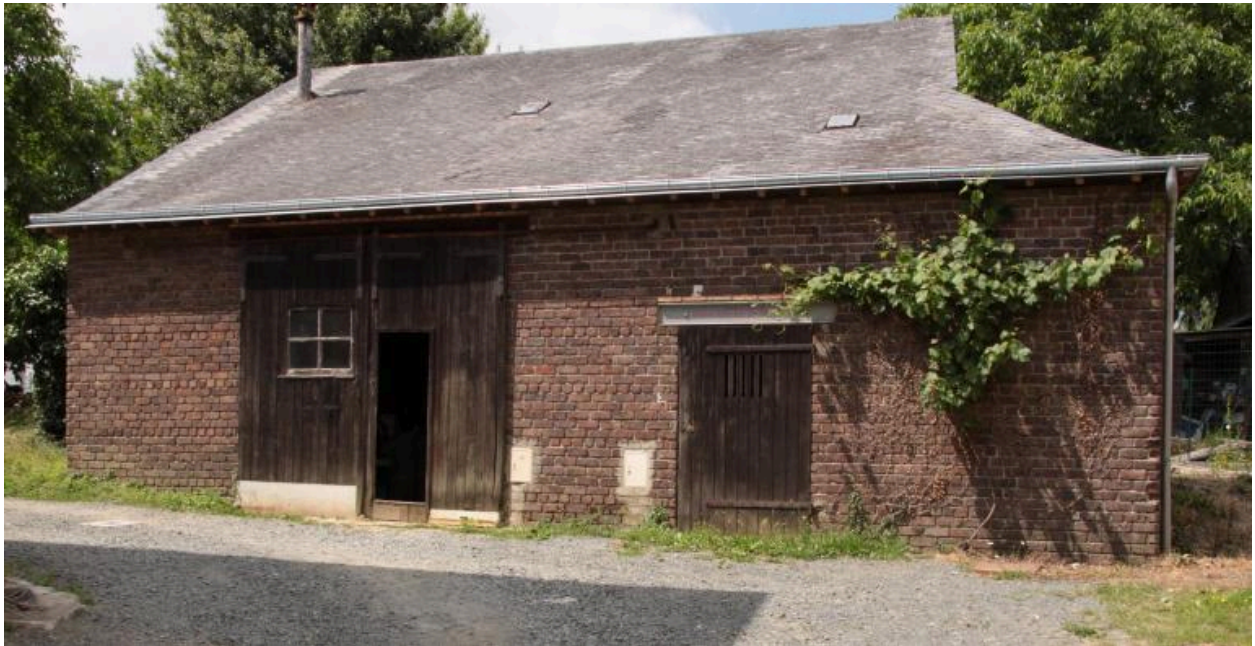
3, chemin de la mare : grange-étable.
