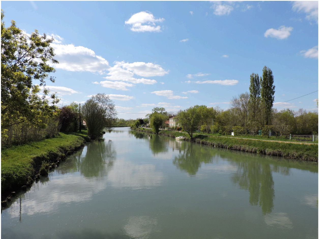
La Sèvre en aval des écluses de Bazoin, vue en direction de l'ouest.
