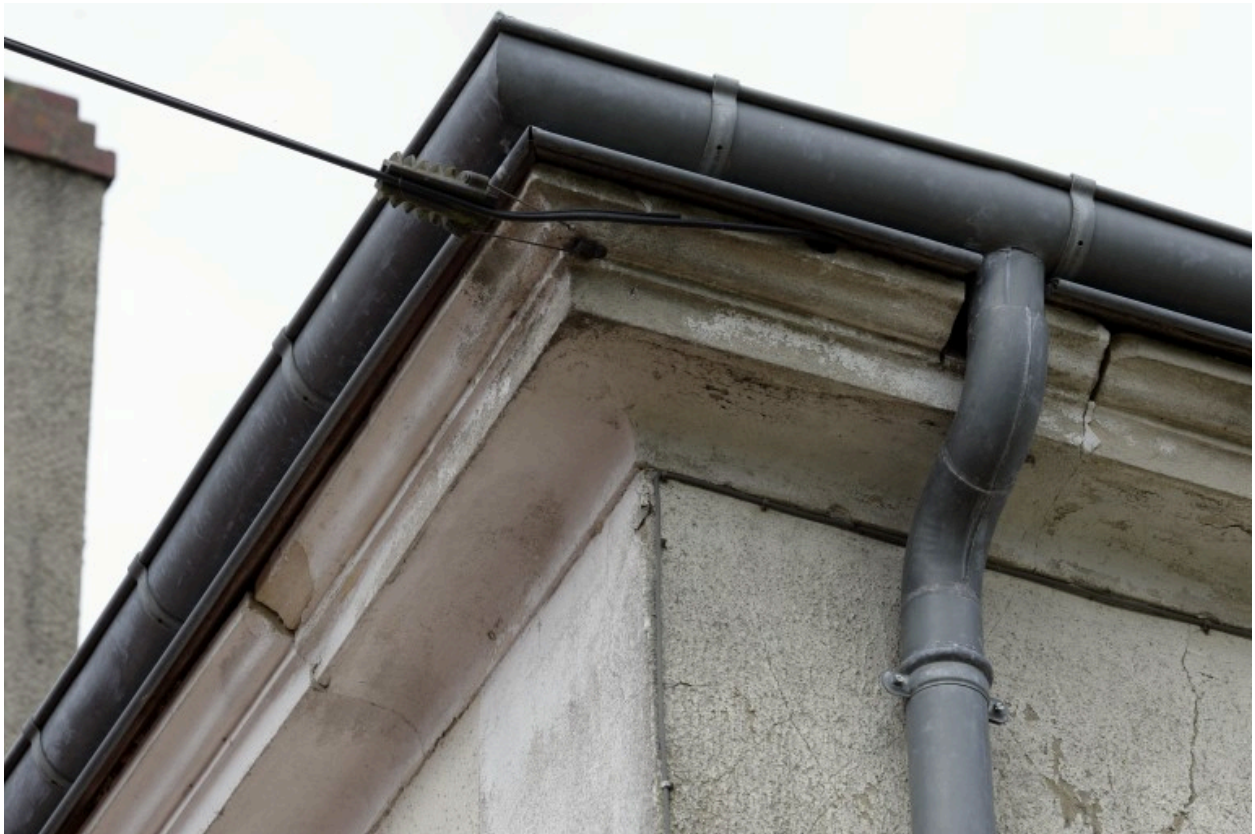
Logis, façade antérieure : détail de la corniche.
