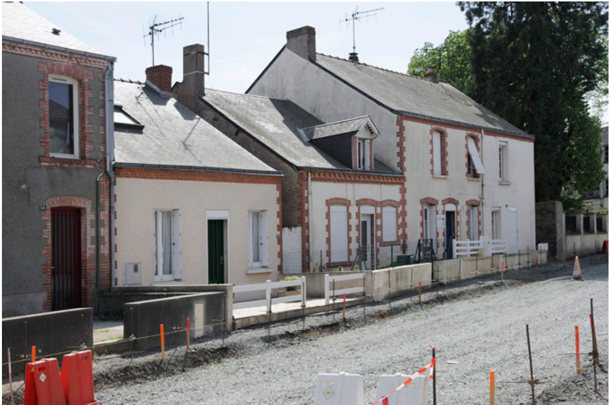
Maisons ouvrières probablement liées à l'usine Repussard-Chupin.
