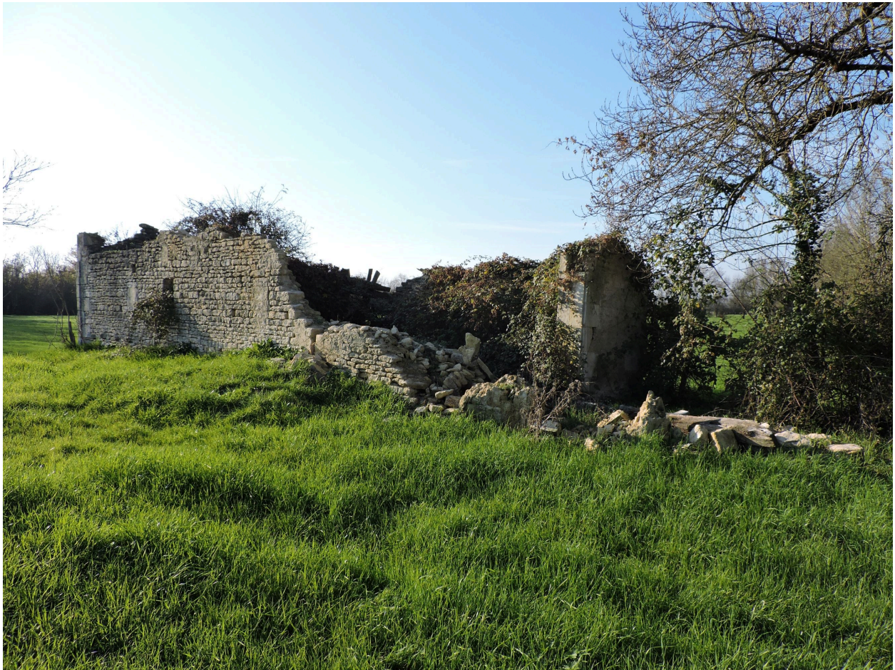
Les ruines vues depuis l'est.
